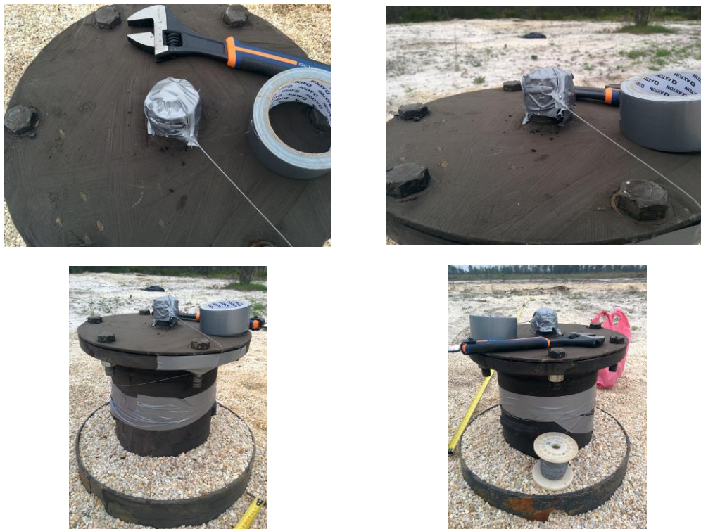
Figura 4.19 – Instalação e acoplagem da sonda digital à tubagem definitiva da captação RAQ023 (RA1 - LSM1)
