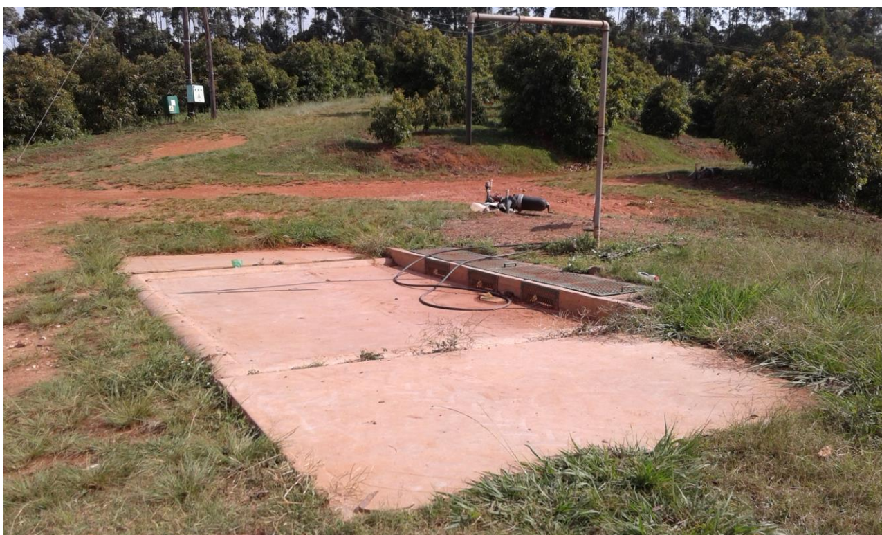
Figura 4.12 – Bacia de lavagem do pulverizador
