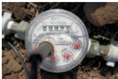
Figura 4.21 – Caudalímetro
